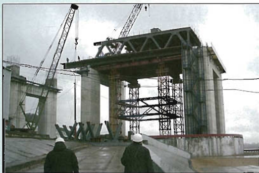
Рис. 2. Сборный стапель в пролете 14–15а
