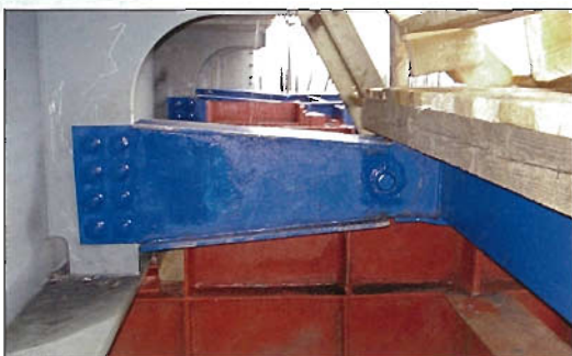
Рис. 5. Конструкция анкервки (узел 2)
