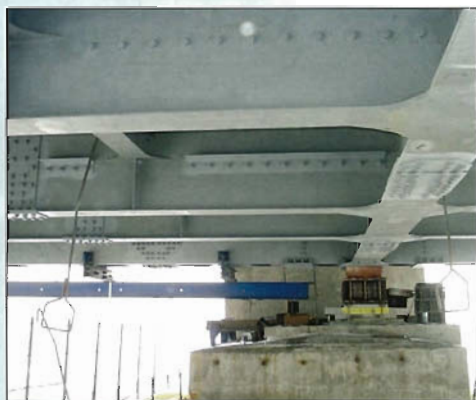
Рис. 12. Усиление стенок продольных балок
