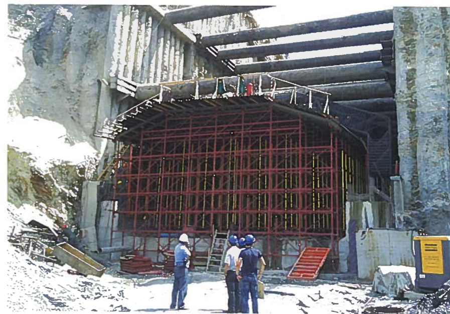
Сооружение перекрытия тоннеля
