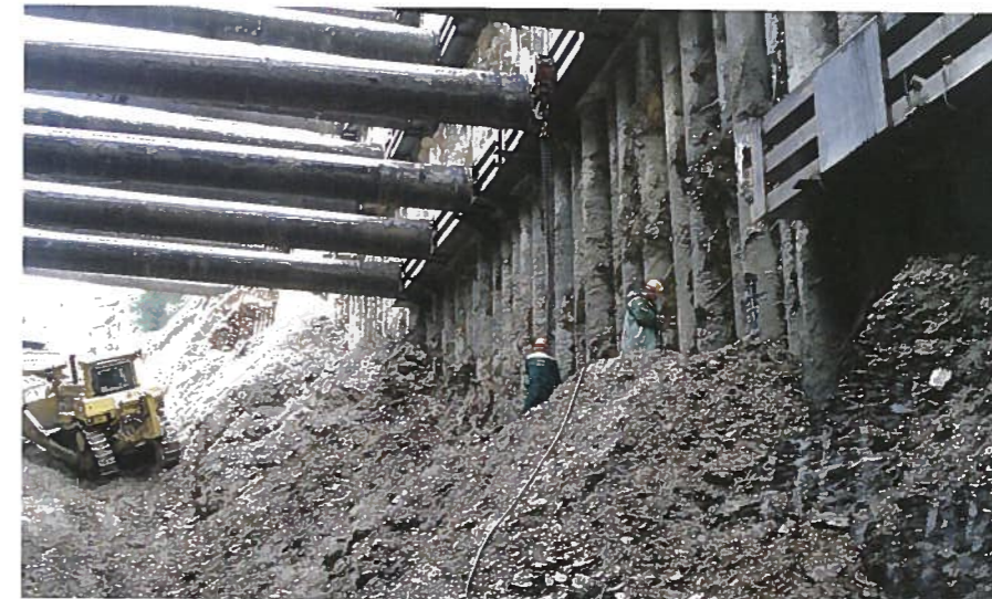
Сооружение распорного крепления
