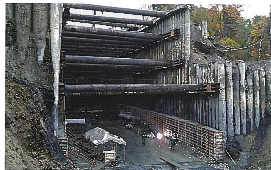
Сооружение лотка и стен тоннеля
