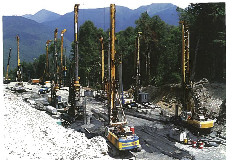
Сооружение ограждающих стен на тоннеле на ПК86
