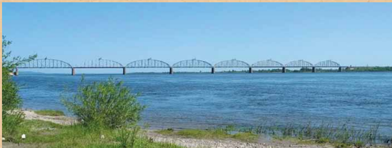
Мост через реку Зею, ст.Призейская
